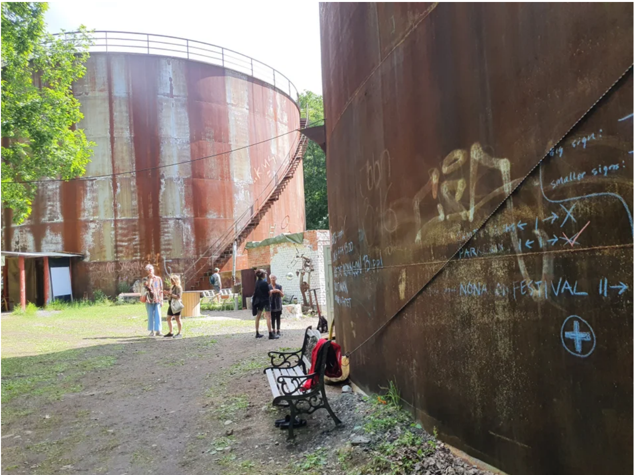
Cisternerna på Svanö. Bild: Gregor Flakierski
